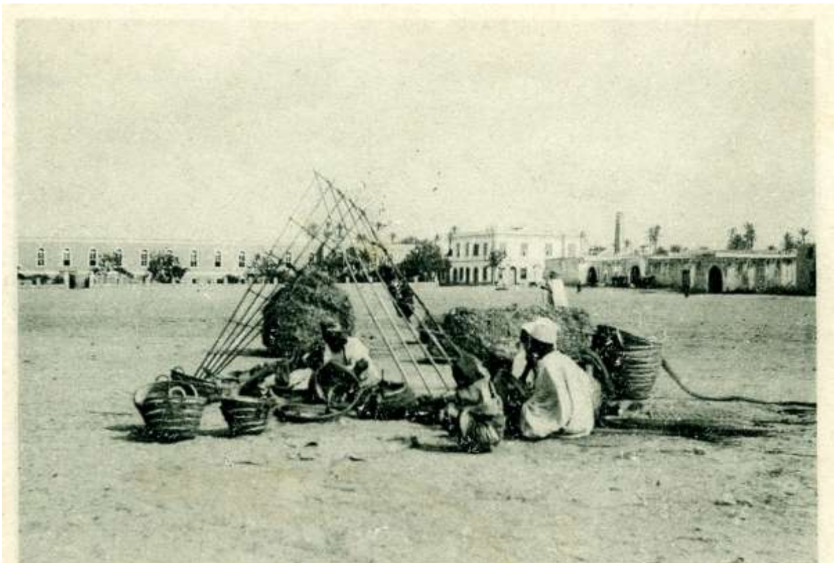
TRIPOLI - L'ossatura di una tenda di Fabbricante di Caffè di Sparto In fondo una Caserma
