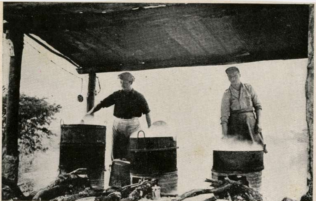
71. Cucine di cantiere (Ditta Avalor).
